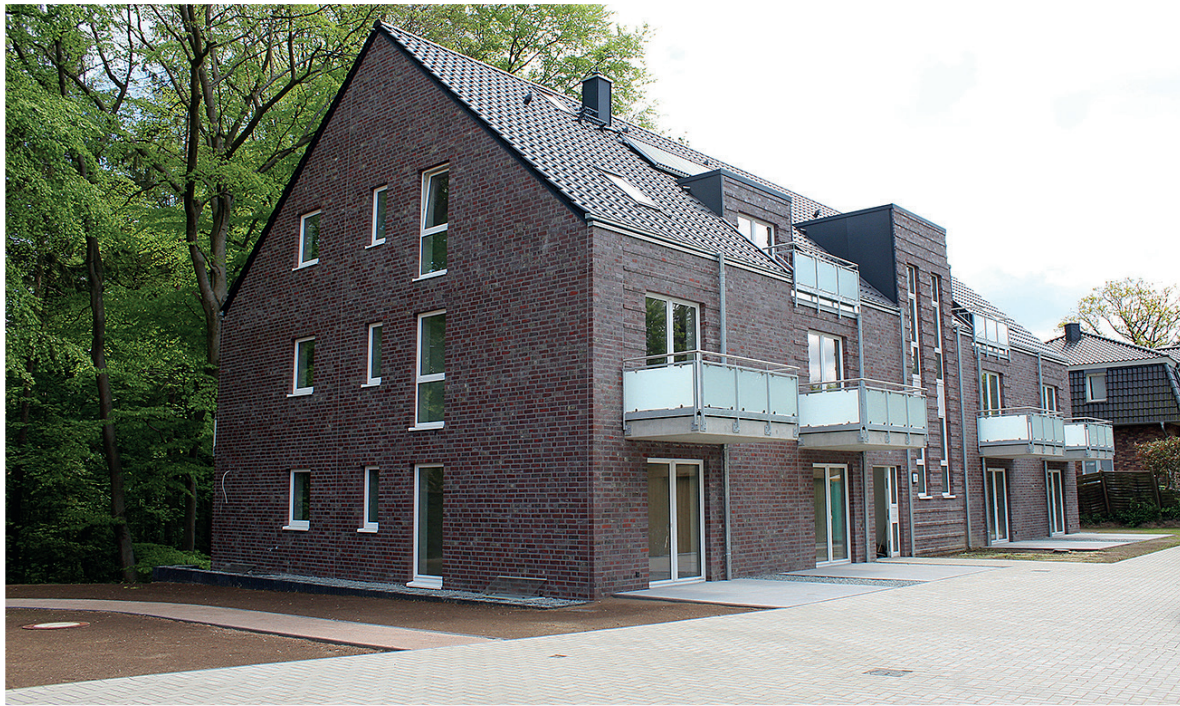
Haus 2 der Wohnanlage „Am Schlosspark“ wird im Juni bezugsfertig sein Fotos: sb
