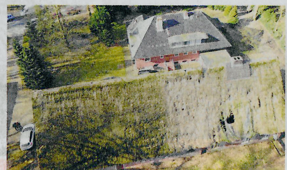
Luftaufnahme vor dem Abbau: Der Hof mit dem maroden Strohdach, daneben das jüngere Einfamilienhaus, wo die Investoren eine Kita planen. FOTO: SCHULENBURG
